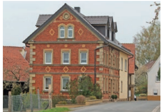
Ein wahres Kunstwerk ist dieses Backsteinhaus in der Ortsmitte. Um 1900 ist diese Bauweise in der Gegend aufgekommen.
