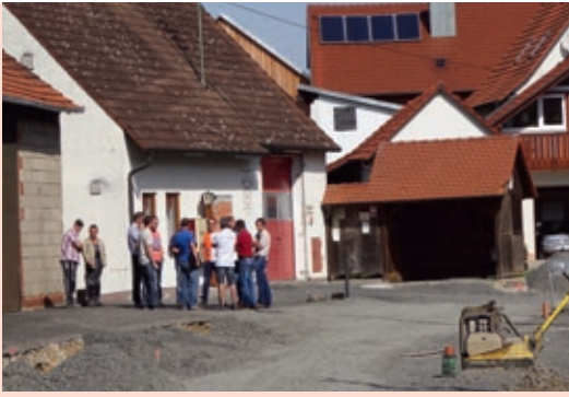
Die Sanierung der Ortsdurchfahrtsstraße in Losbergsgereuth wurde 2016 abgeschlossen.
