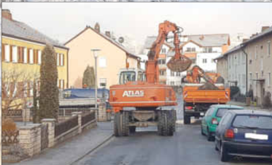
Bauarbeiten am Wasserrohrbruch in der Adalbert-Stifter-Straße in Ebern
