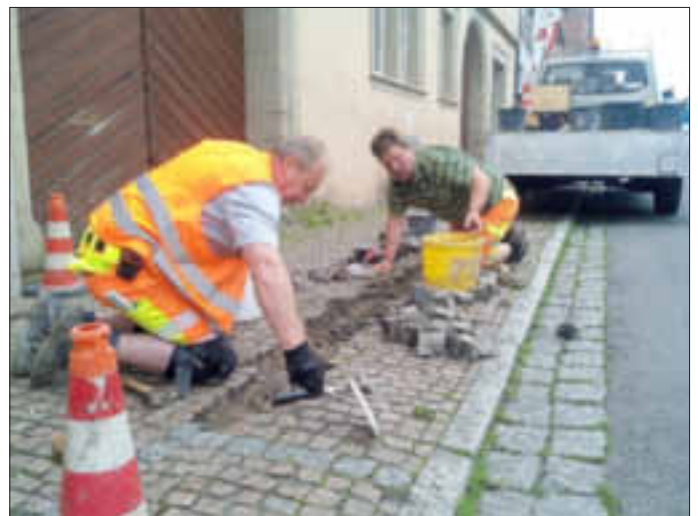
Die Mitarbeiter des Bauhofs bei Pflasterarbeiten am Marktplatz
