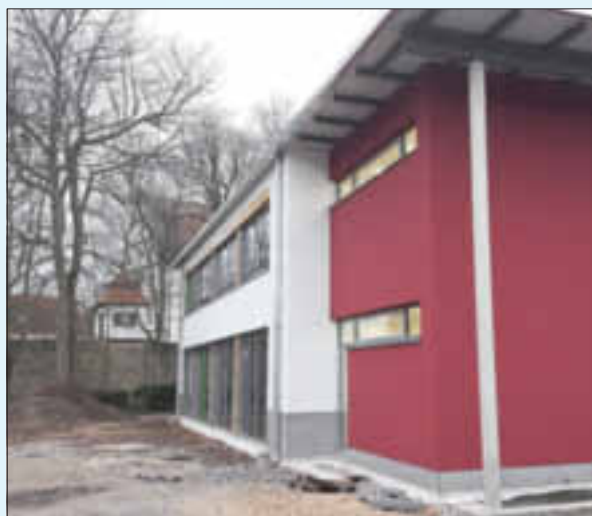
Das neue Betreuungsgebäude für die Grundschüler neben dem Bahnhof
