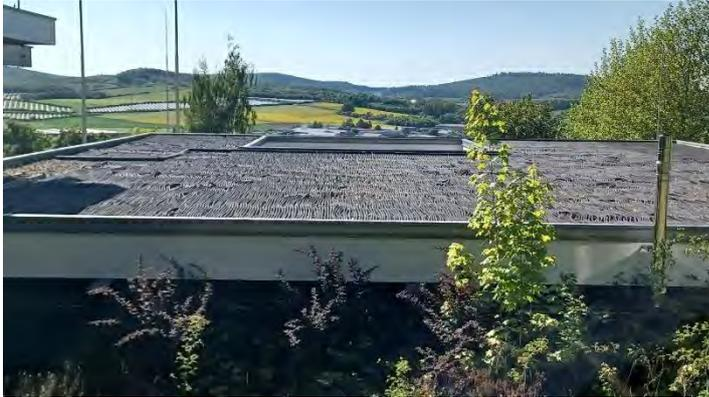
Im Freibad wurde durch den Einsatz von Solarkollektoren auf den Betriebsgebäuden bei der Erwärmung des Wassers in den Schwimmbecken fast die Hälfte des Gasverbrauches eingespart. Durch eine gezielte Steuerung der Solaranlage zur rechtzeitigen Erwärmung lässt sich sehr gut Gas einsparen.
