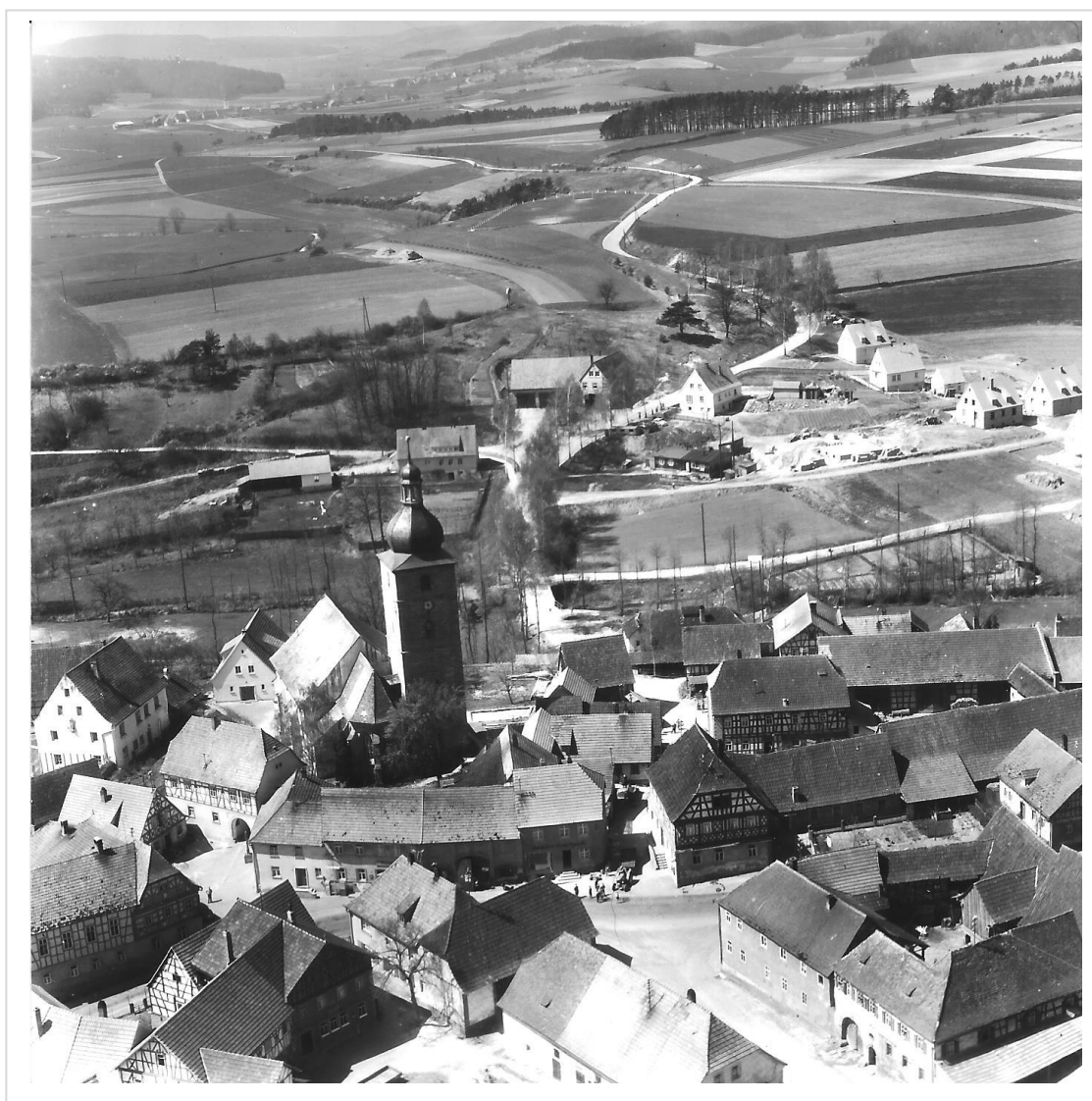
Haus Nr. 51, 52, 53, 54 rechts neben dem Torbogenhaus 1957 Bildmitte rechts neben dem Torbogenhaus, vor der Kirche
