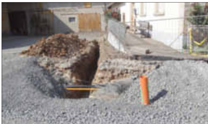
Neue Leitungen bis ins Haus, das wartet auf die Bürgerinnen und Bürger in Losbergsgereuth.
