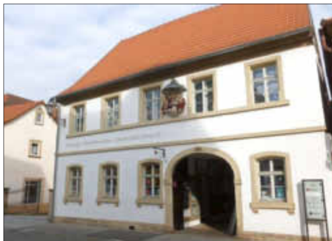
Saniertes Anwesen Ritter-von-Schmitt-Str. 8 in Ebern
