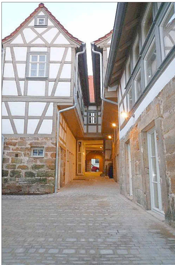
Rückgebäude des sanierten Anwesens Ritter-von-Schmitt-Str. 8 in Ebern
