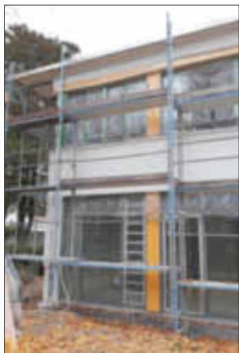
Etwas Farbe am Gebäude ist schon zu erkennen. Die Malerarbeiten laufen derzeit.
